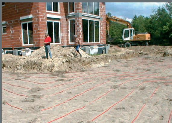
Размеры коллектора зависят от количества употребляемого тепла, а также от геофизических условий почвы. Чем влажнее и плотнее почва, тем больше тепла может накопить, и отдать для обогрева.
